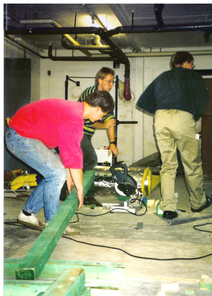
Umbauarbeiten in der Bootshalle
