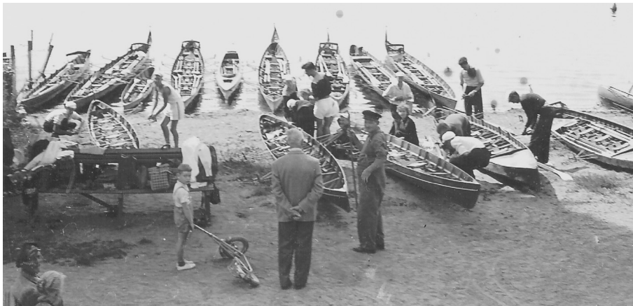
Start am Güterbahnhof in Plön
