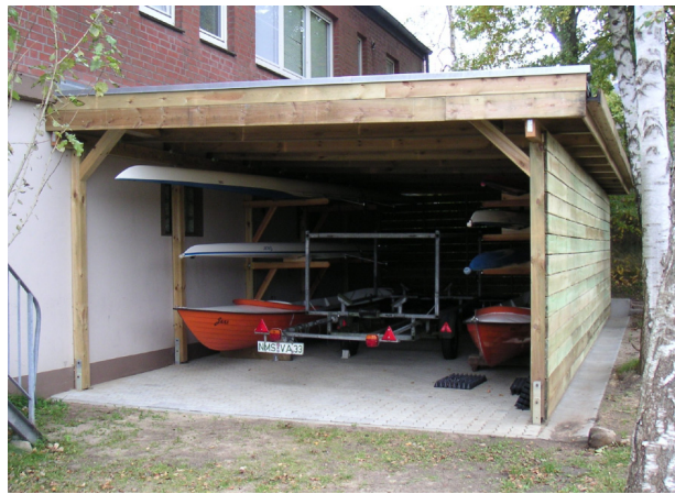
Unser neuer Carport
